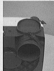
Le piquage est prêt à recevoir le conduit de rejet.
